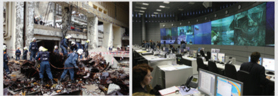
▲ 17 АВГУСТА 2009 ГОДА НА САЯНО-ШУШЕНСКОЙ ГЭС В РЕЗУЛЬТАТЕ АВАРИИ МНОГОЭТАЖНОГО ГИДРОАГРЕГАТА БЫЛ ЧАСТИЧНО РАЗРУШЕН И ЗАТОПЛЕН МАШИННЫЙ ЗАЛ. АВАРИЯ ПРИВЕЛА К ЧЕЛОВЕЧЕСКИМ ЖЕРТВАМ. В ХОДЕ СОВМЕСТНЫХ УСИЛИЙ УДАЛОСЬ СПАСТИ ЛЮДЕЙ, ОПЕРАТИВНО ОРГАНИЗОВАТЬ АВАРИЙНЫЙ ВОДОСВРОС, ВОССТАНОВИТЬ ЗАТВОРЫ, ОТКАЧАТЬ ВОДУ И РАСЧИСТИТЬ ОТ ЗАВАЛОВ МАШИННЫЙ ЗАЛ.
